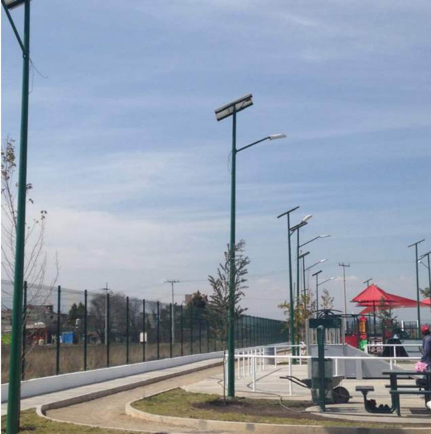
Kit Solar - Lámpara LED tipo CREE 53W, panel solar fotovoltaico 150W, batería, Inversor, convertidor y controlador
