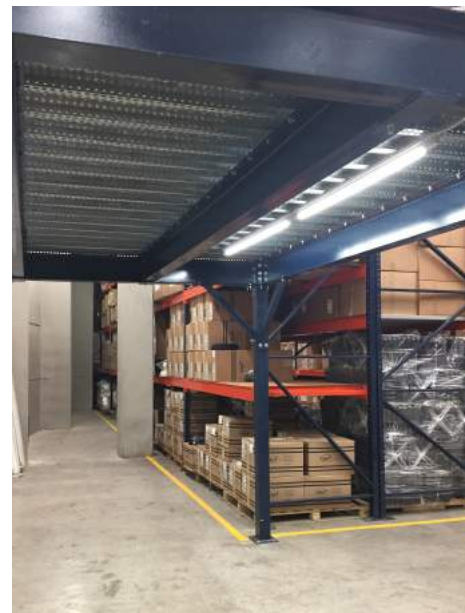
Tubo T8 LED, 20W, acabado opaco, 5000K en gabinete de aluminio color blanco sin difusor
